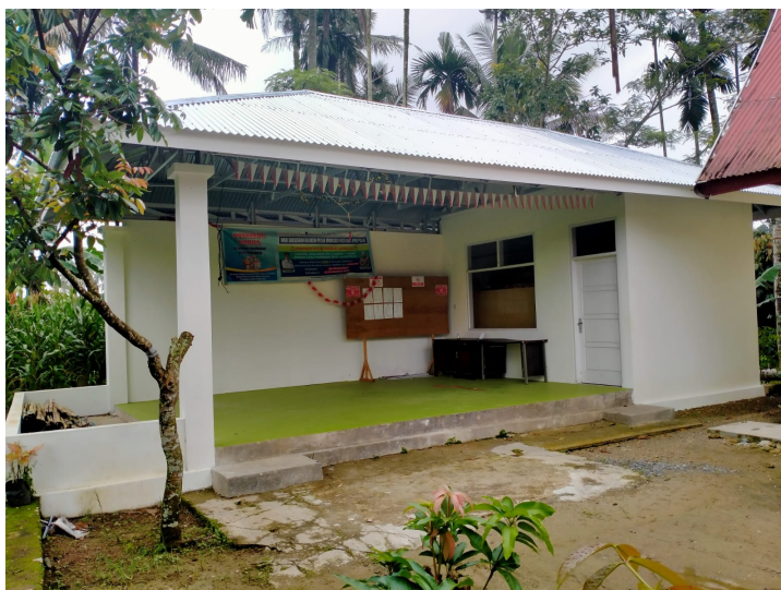
Pembangunan sarana dan prasarana kesehatan (gedung posyandu)
