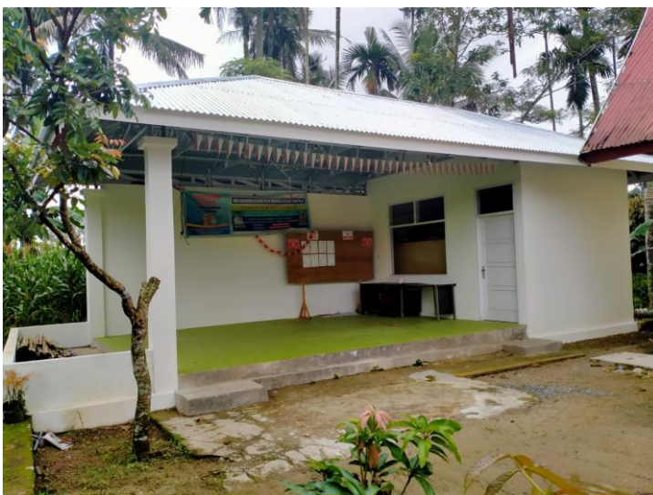
Pembangunan sarana dan prasarana kesehatan (gedung posyandu)
